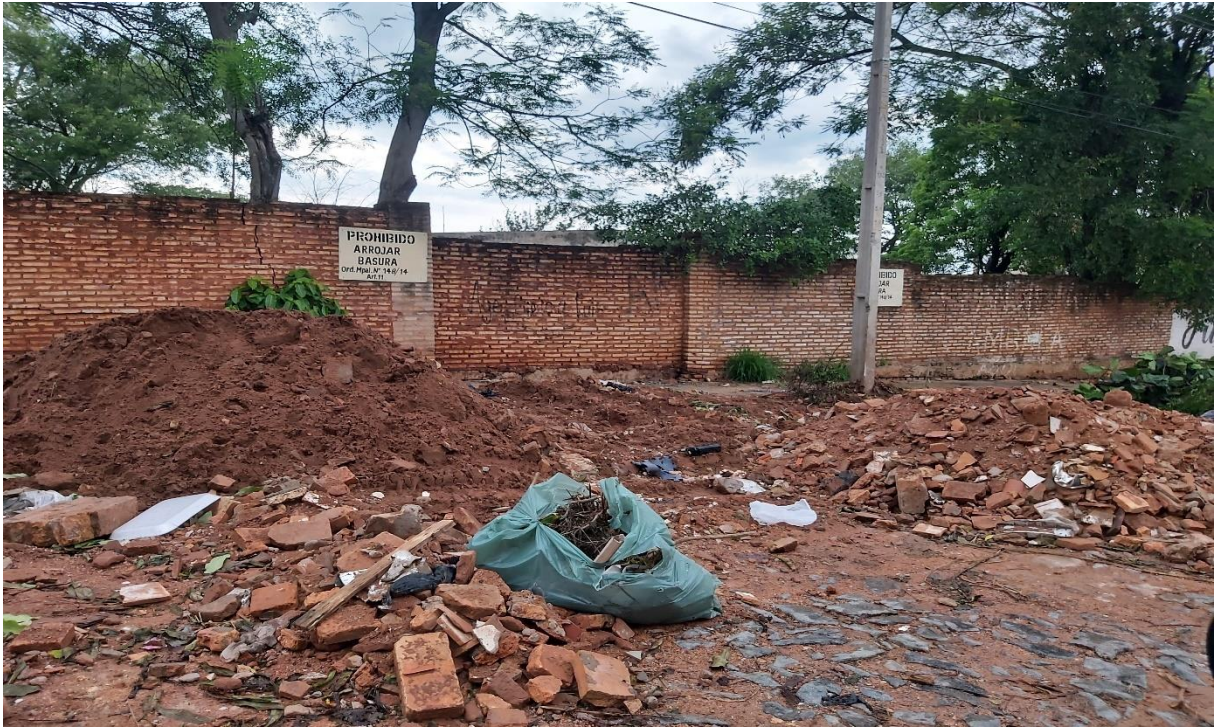
Residuo de la construcción civil.
